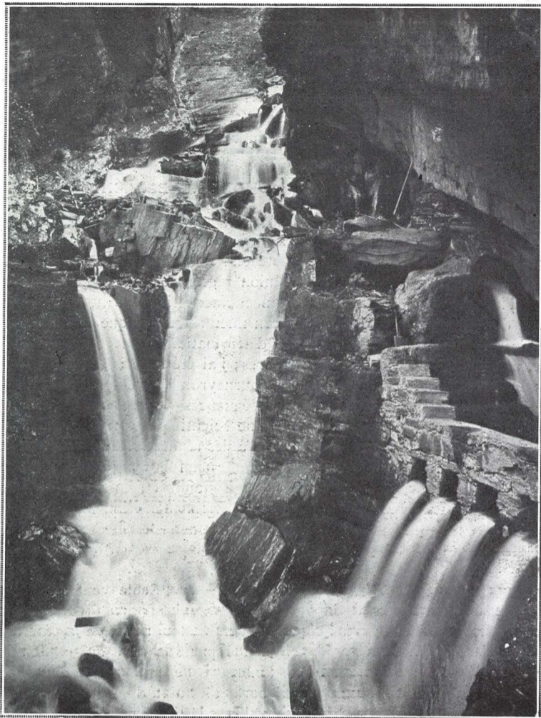
Prise d'eau du ruisseau de Lancey pour la première chute de 200 mètres aménagée par Aristide Bergès.
